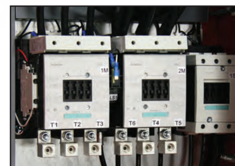
• Ensemble de contacteurs étoile/triangle
