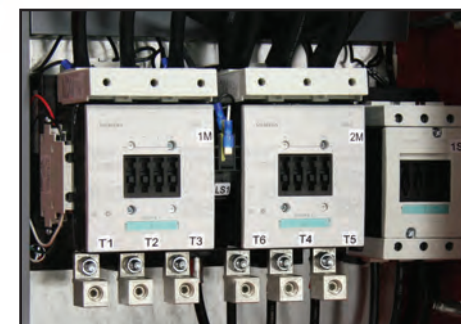
• Ensemble de contacteurs étoile/triangle
