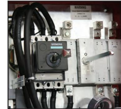
• Sectionneur d'isolement et disjoncteur
